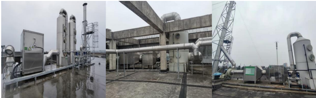
图E-2 废气处理设施
